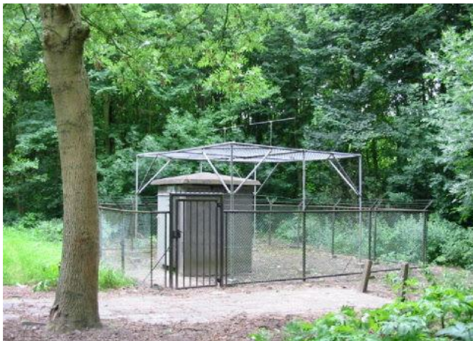
Installation au sol d'un OUTER MARKER
